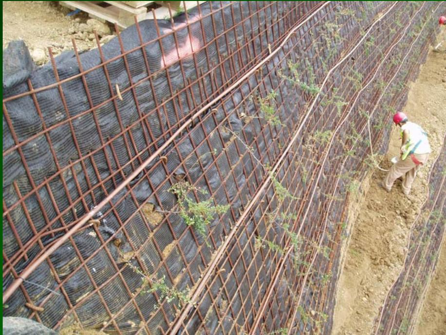
Recuperación de un talud en Bilbao inoculando Glomygel® en la planta *Cotoneaster sp.* Trabajos realizados por la empresa medioambiental TECONMA S.A.
