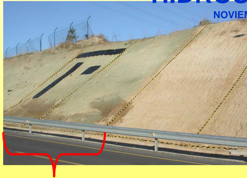
HIDROSEMBRADO CON MEZCLA COMERCIAL
