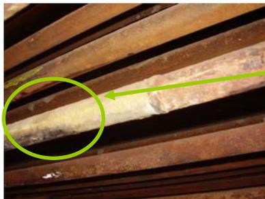
**DESGASTE DEL RECUBRIMIENTO DEL TESTIGO COLOCADO EN LA PARADA DE 2007**
