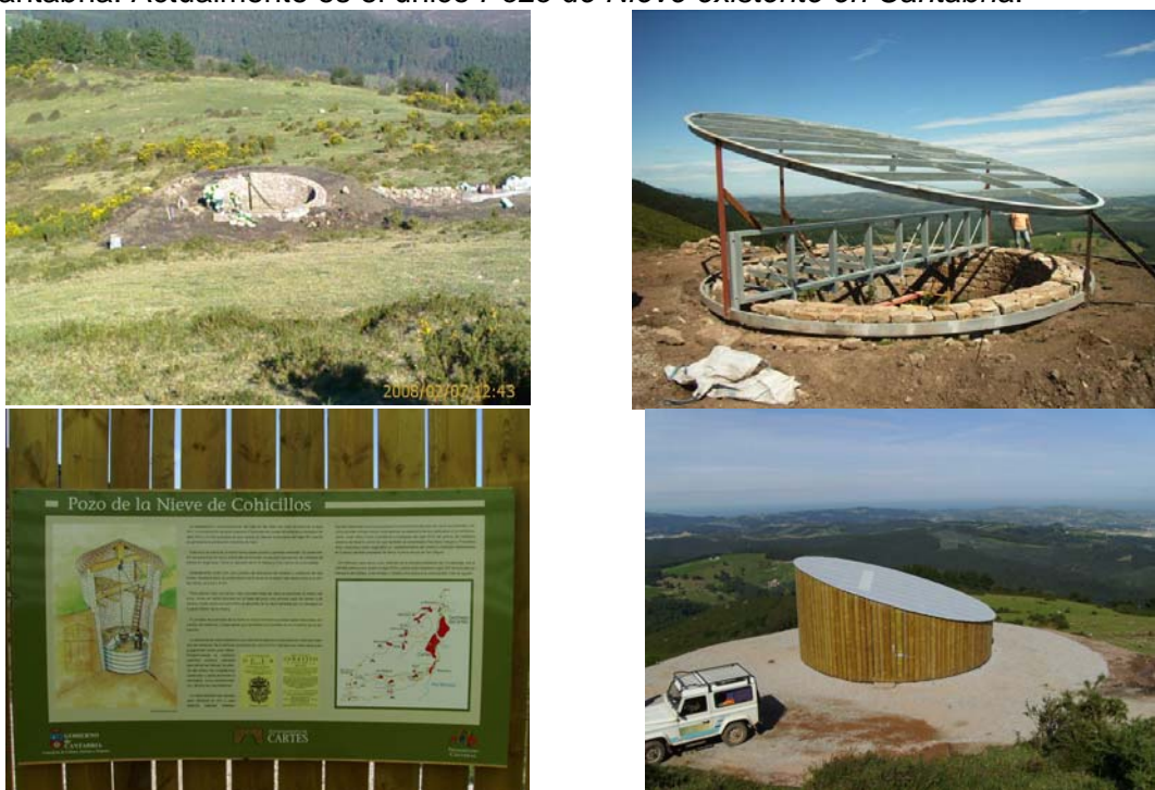
Fotos: Recuperación del pozo de Nieve
