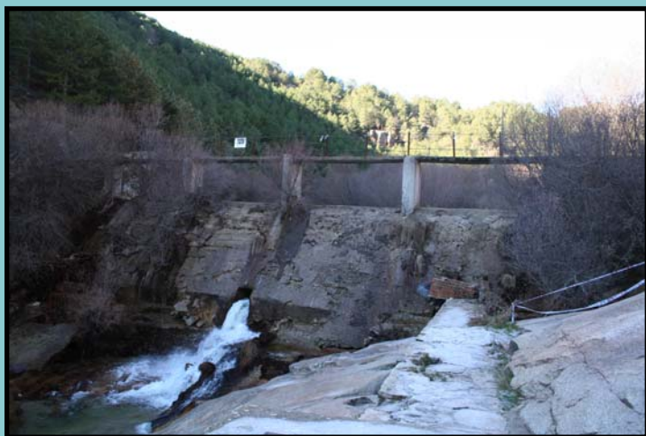
Estado original de la presa
