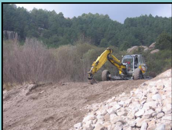
Movimientos de tierras con “retroaraña”
