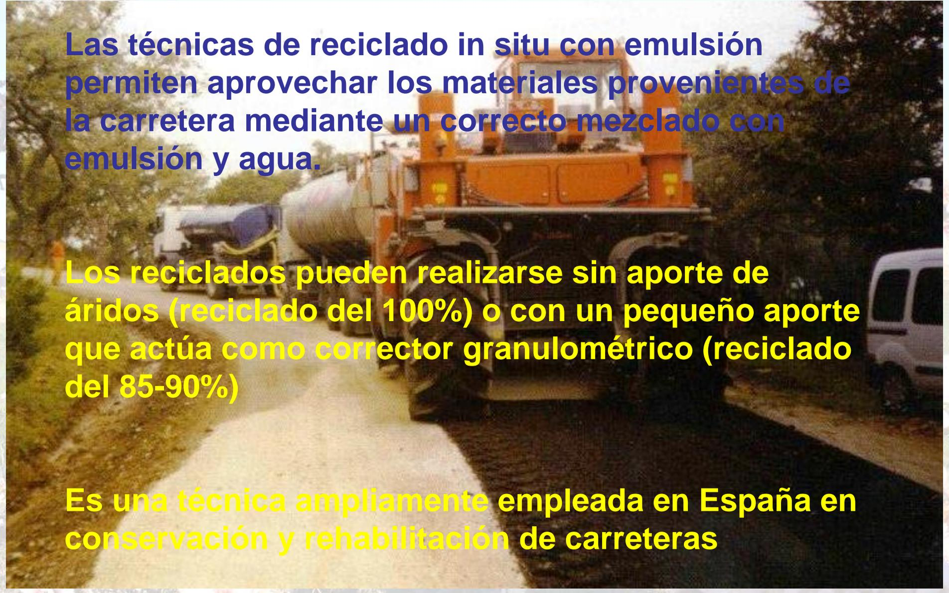
**Las técnicas de reciclado in situ con emulsión permiten aprovechar los materiales provenientes de la carretera mediante un correcto mezclado con emulsión y agua.**
