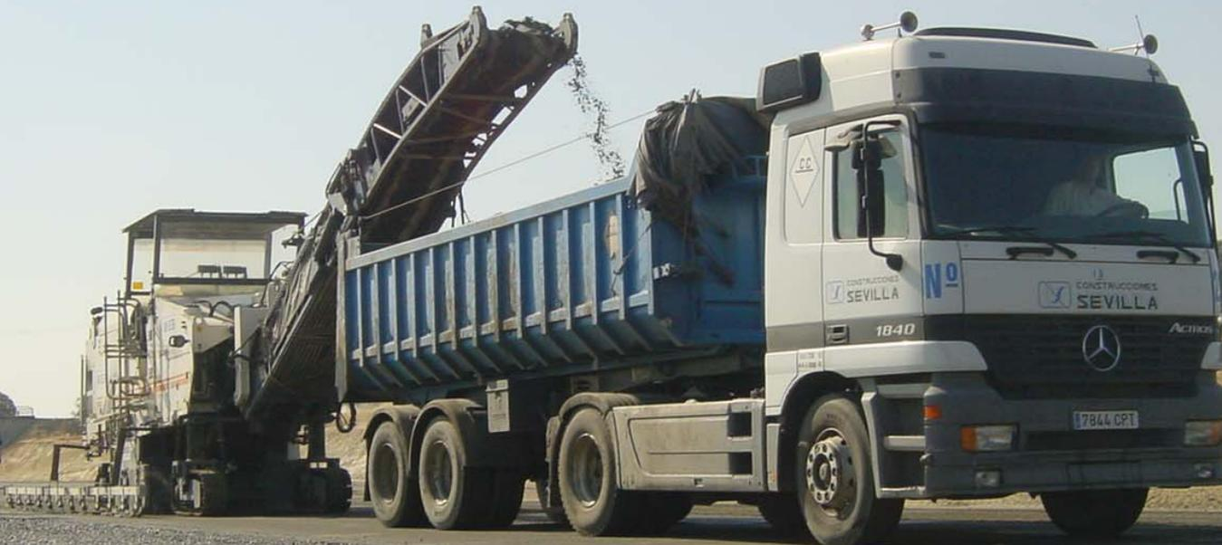
Las técnicas de fresado permiten, no sólo reaprovechar los materiales de las mezclas bituminosas existentes, sino también corregir diversos tipos de deterioros
