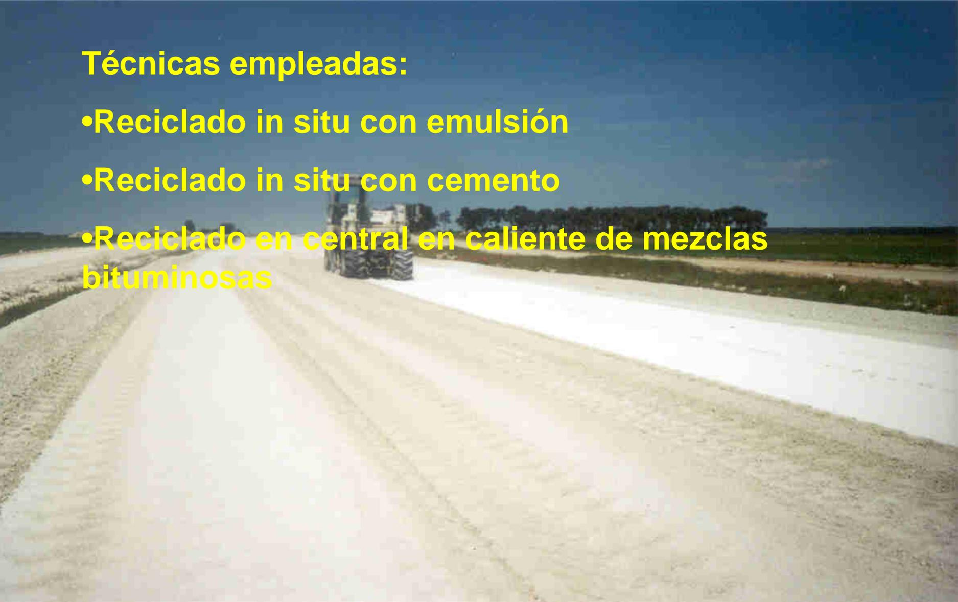
Las técnicas de reciclado in situ con cemento aprovechan el material existente en la carretera, regenerando sus propiedades mediante el mezclado con cemento y ocasionalmente un corrector granulométrico (grava o zahorra)
