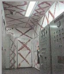
Marcando zonas de amianto
