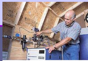
Generador de ozono en una planta potabilizadora
