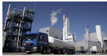
Planta de captura de CO2 de Vattenfall (Alemania).
