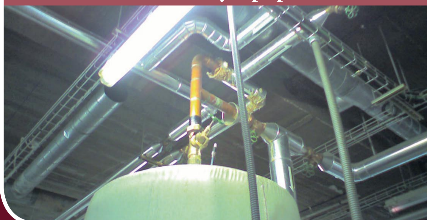
Caldera y equipos de distribución de Agua Caliente Sanitaria
