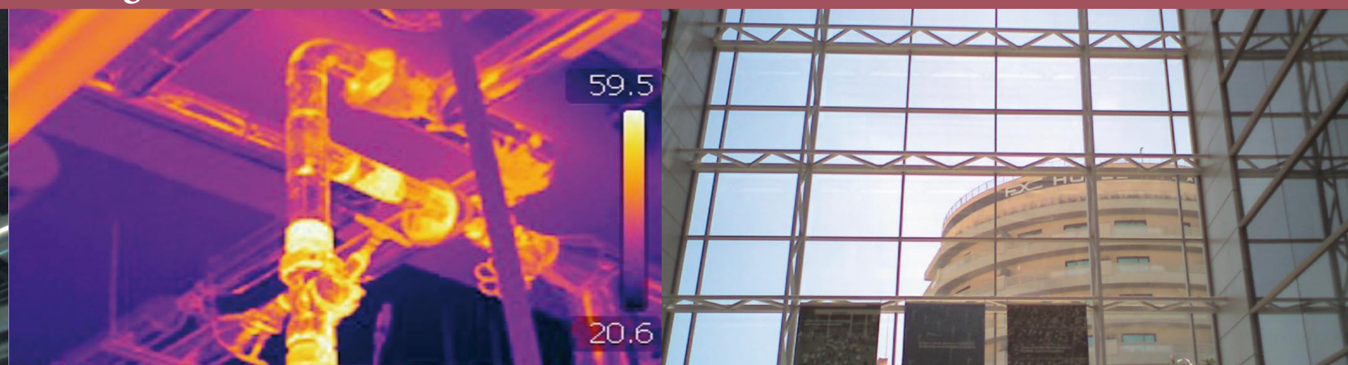
Caldera y equipos de distribución de Agua Caliente Sanitaria
