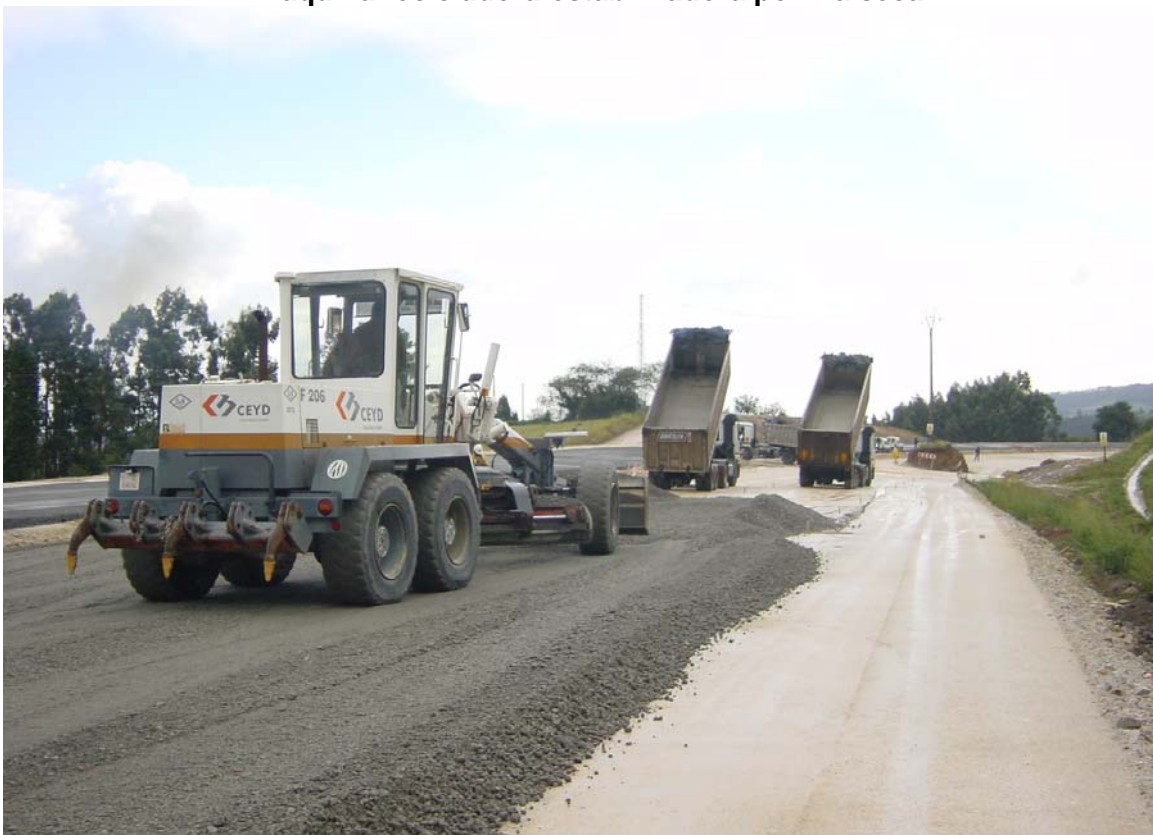
Subbase de escoria cristalizada en Autopista A-8, tramo: Gijón-Villaviciosa (Asturias)
