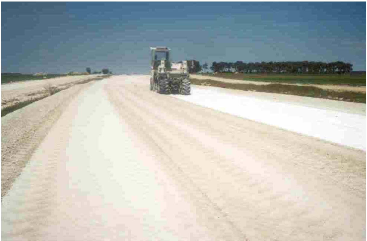
Estabilización con cal de suelos margosos en la Variante de San Miguel del Arroyo (Valladolid)
