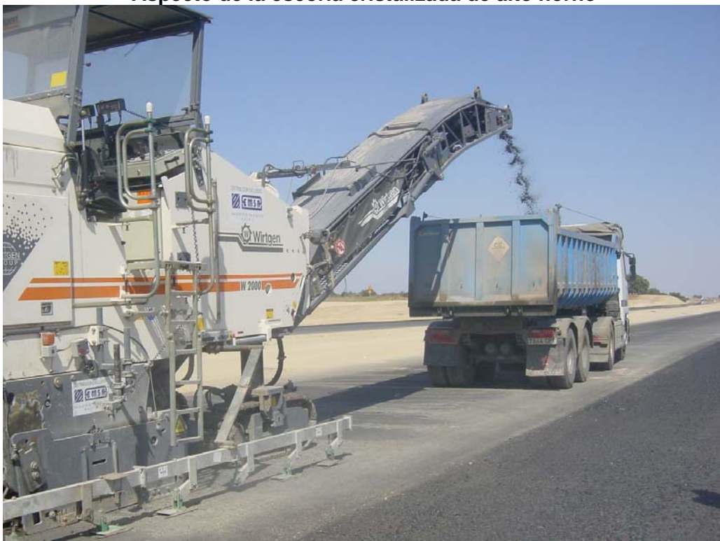
Fresado de pavimento en la autovía EX-A1, tramo: Navalmoral-Río Tietar
