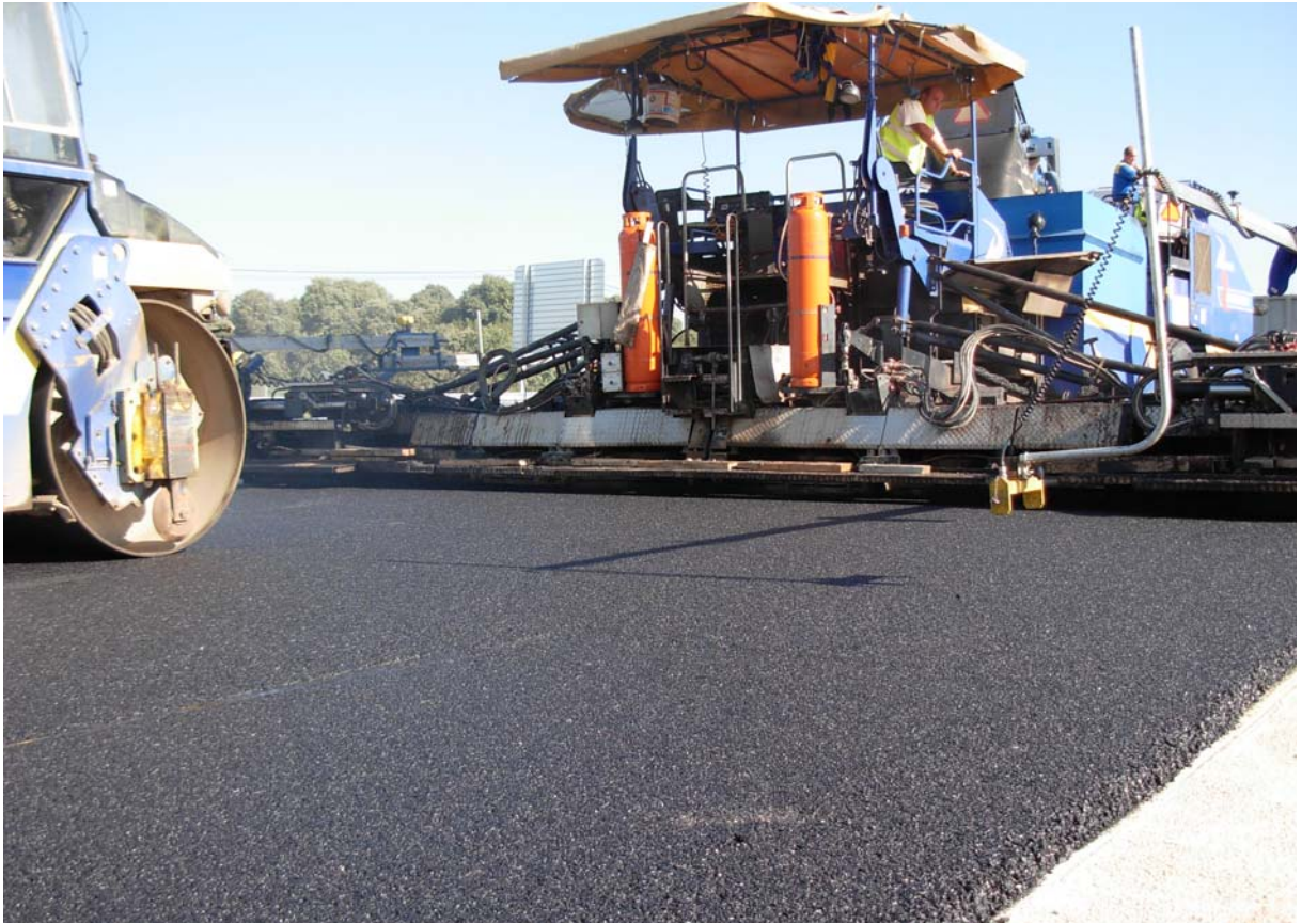
Aspecto de la capa de rodadura con mezcla de betún caucho en la autovía M-503
