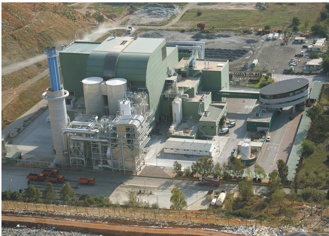
Ilustración 1: Planta incineradora con recuperación de energía de Mallorca.
