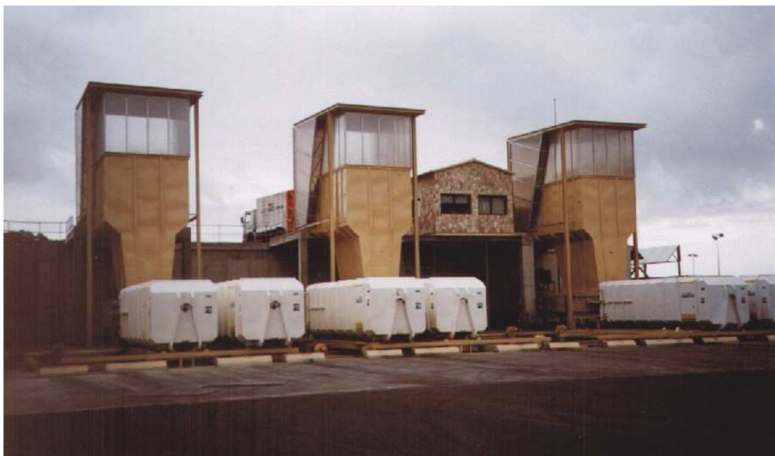
Ilustración 3: Fotografía de una estación de transferencia
