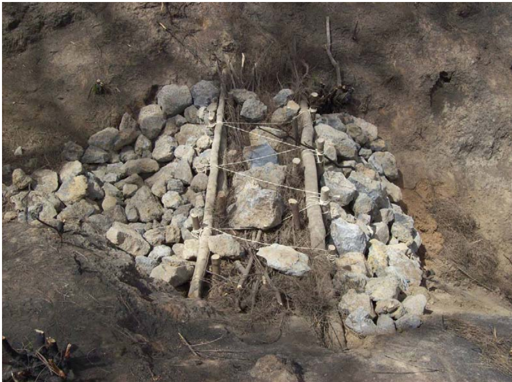
Dique mixto acabado
