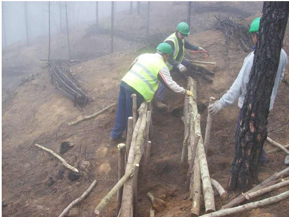
Colocación de la segunda fila elementos verticales
