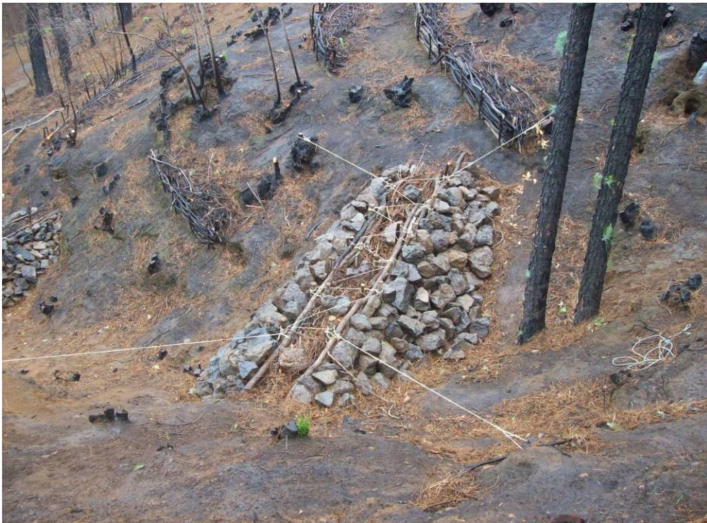
Dique mixto acabado y con anclaje al terreno
