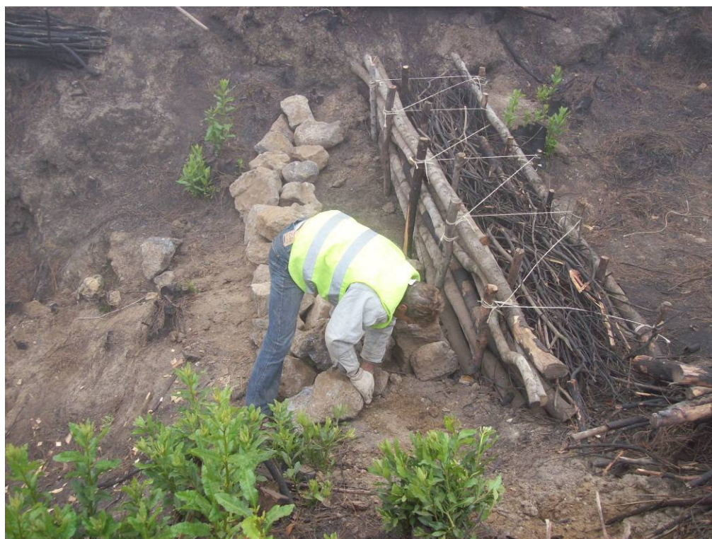
Colocación manual de taludes de piedras
