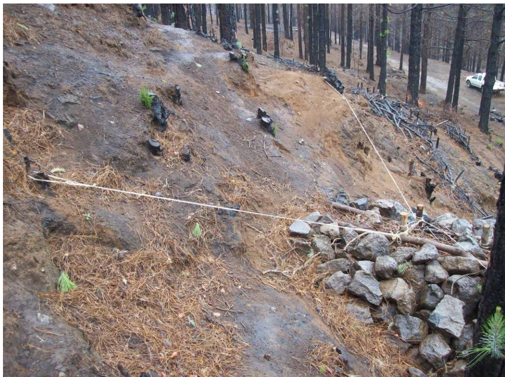
Detalle de anclaje a terreno
