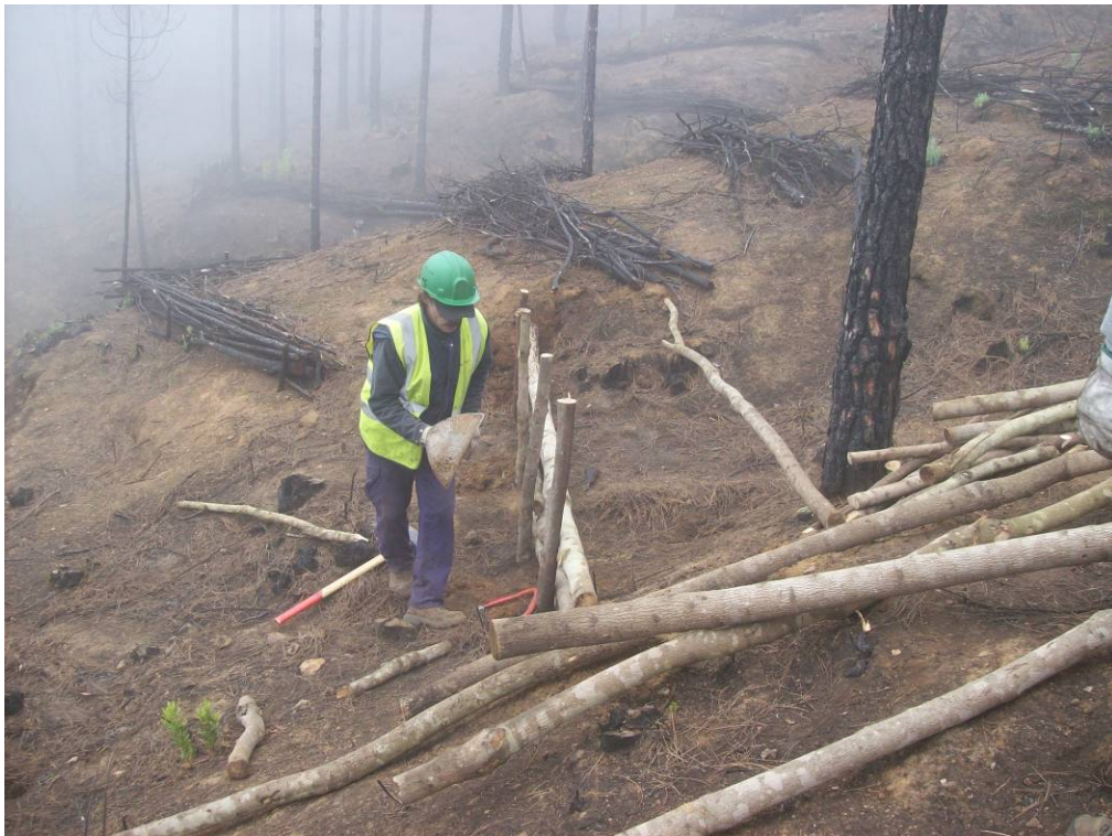
Colocación de elementos verticales
