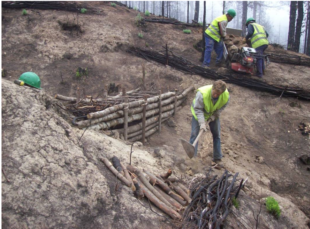
Relleno del dique mixto con materiales procedentes de desbroces y cortas
