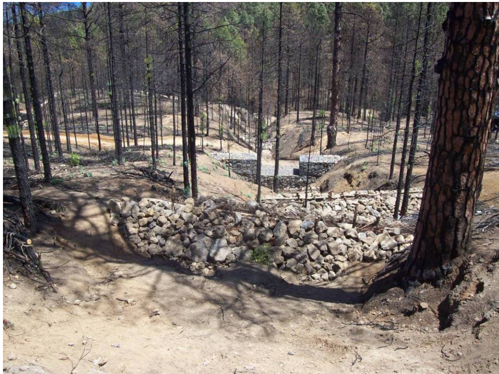
Dique mixto aguas debajo de dique de mampostería gavionada.
