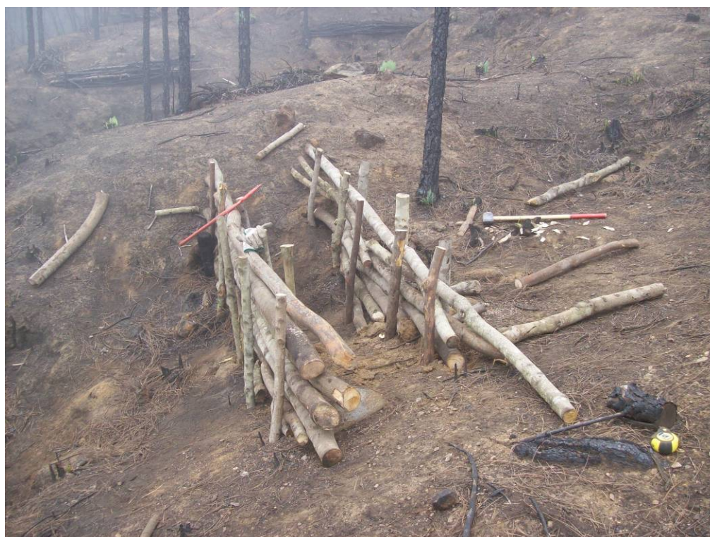
Vista del núcleo del dique mixto
