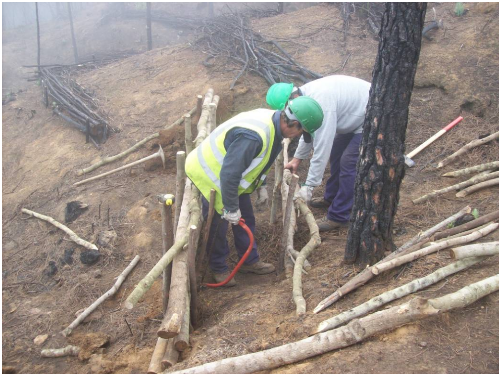
Colocación de la segunda fila elementos verticales
