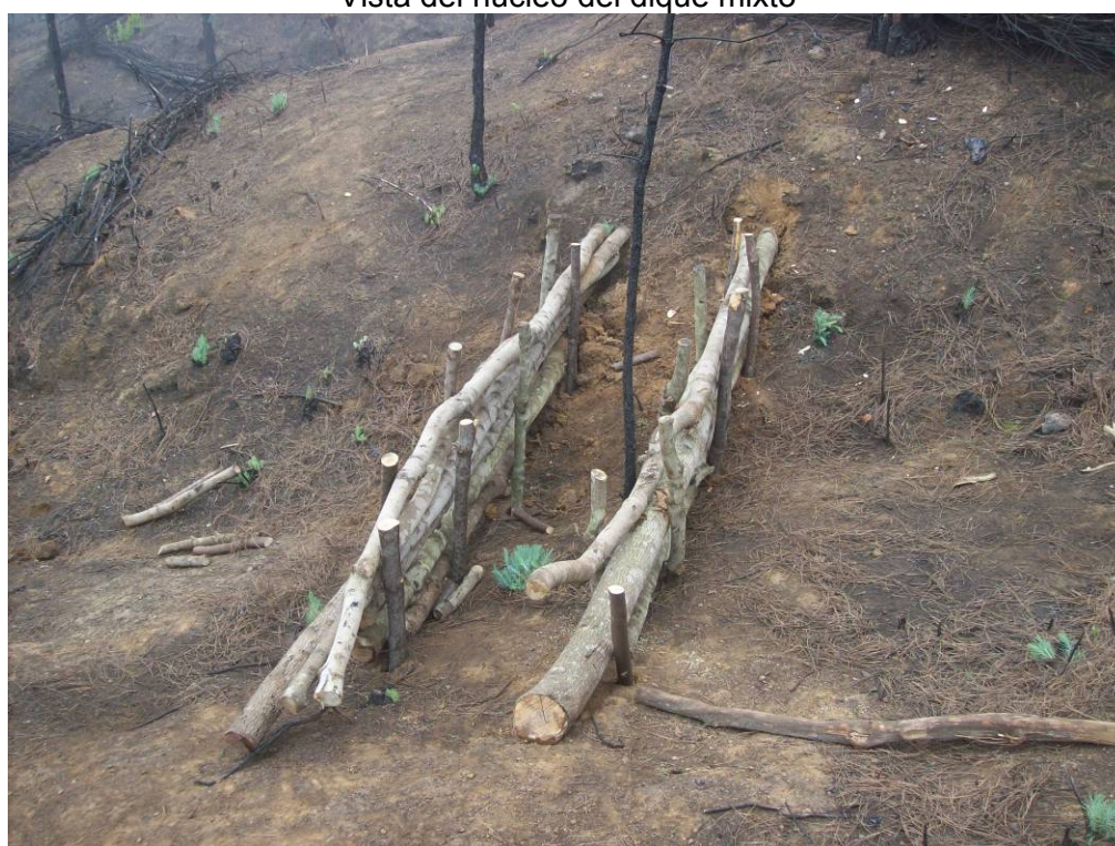
Vista del núcleo del dique mixto
