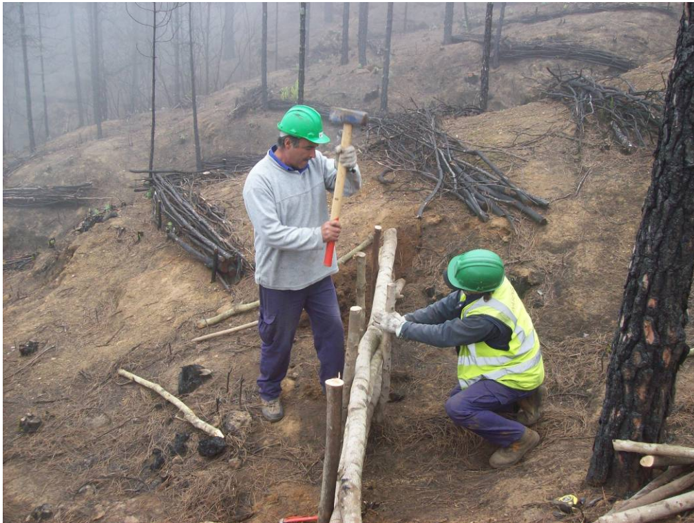
Colocación de elementos verticales
