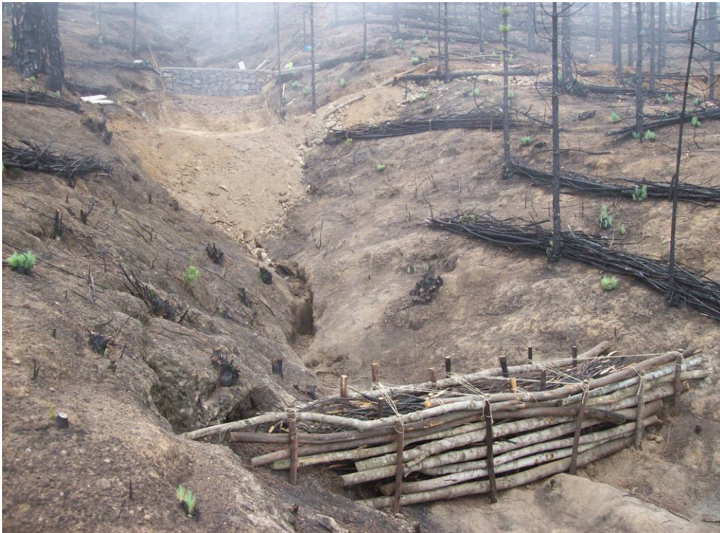
Dique mixto en colaboración con dique de gaviones
