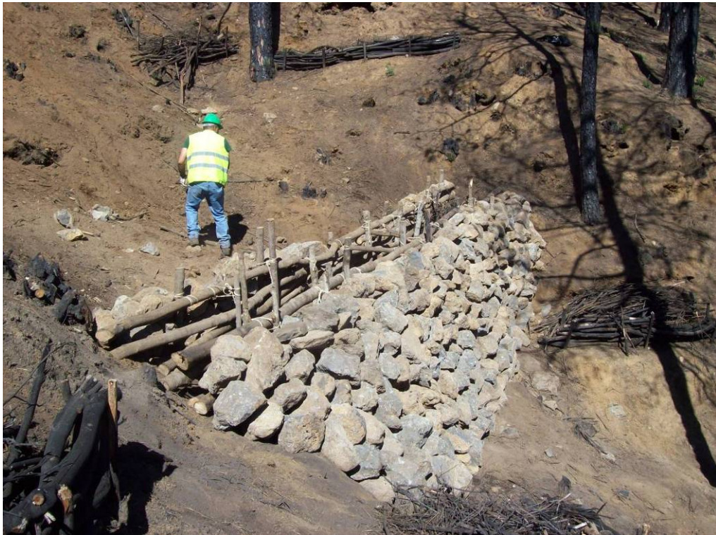
Construcción de dique mixto
