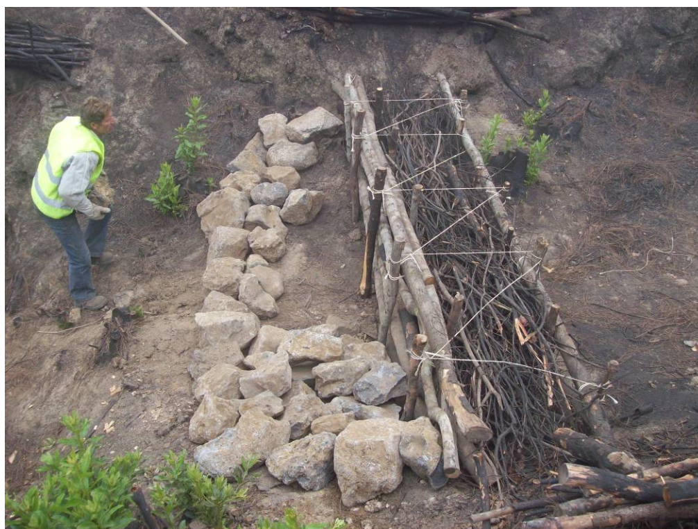
Colocación manual de taludes de piedras
