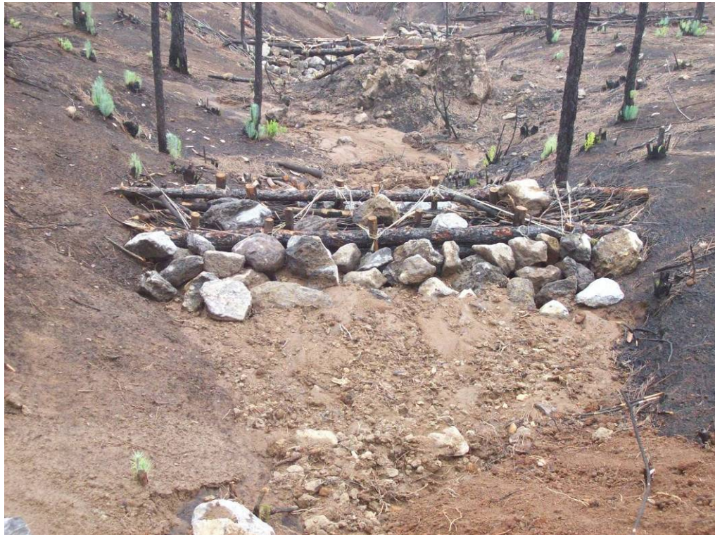
Sedimentación tras primeras lluvias
