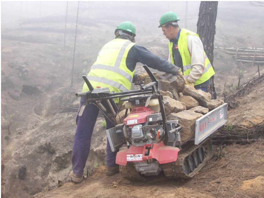
Transporte de piedras hasta emplazamiento de dique mixto
