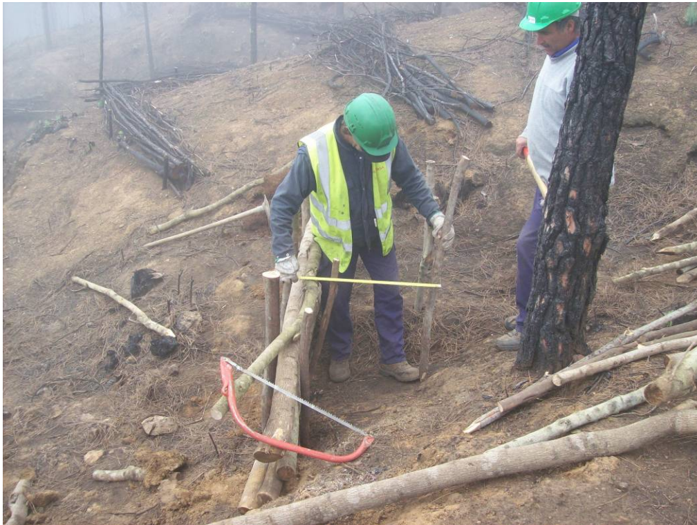
Colocación de la segunda fila elementos verticales
