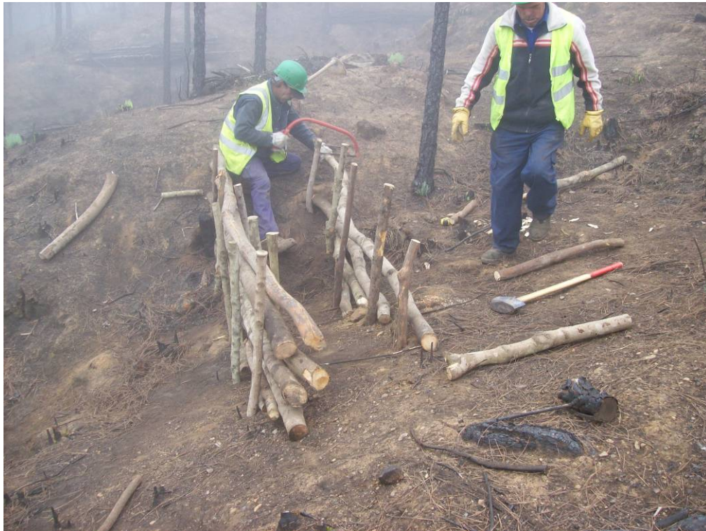
Colocación de la segunda fila elementos verticales
