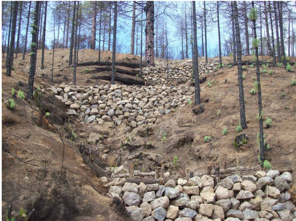
Secuencia de diques mixtos
