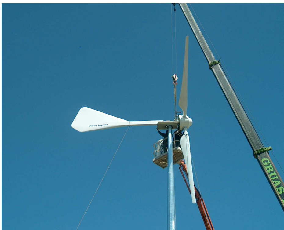
Figura 6. Izado del generador eólico
