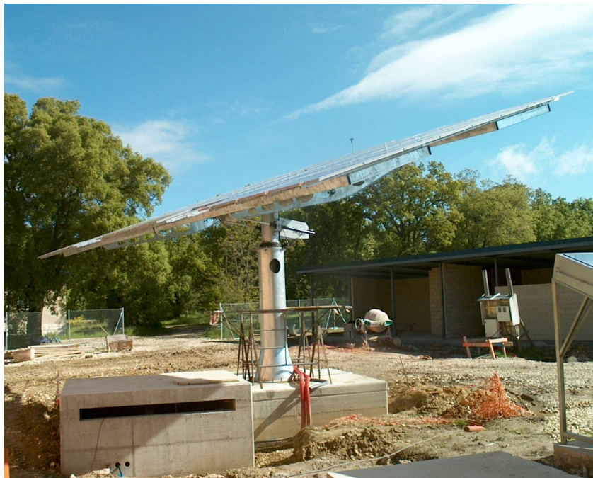
Figura 7. Seguidor solar fotovoltaico
