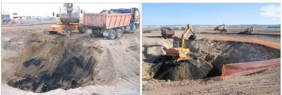
biopilas con un camión dumper de tres ejes con 14m<sup>3</sup> de capacidad.
