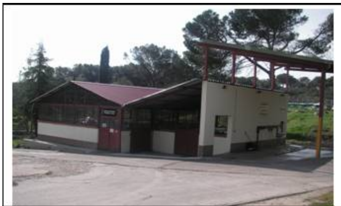
Almacén Final de Residuos.
