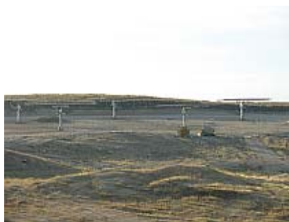
FIGURA 19: Antigua gravera en el término municipal de Casar de Cáceres que actualmente se ha aprovechado para instalar un huerto solar.
