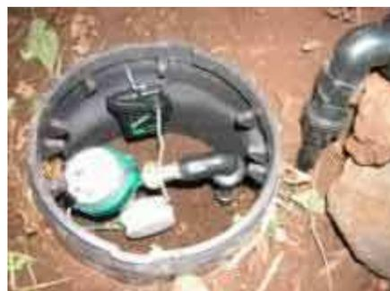
Fig. 21 Contador de impulsos de agua
