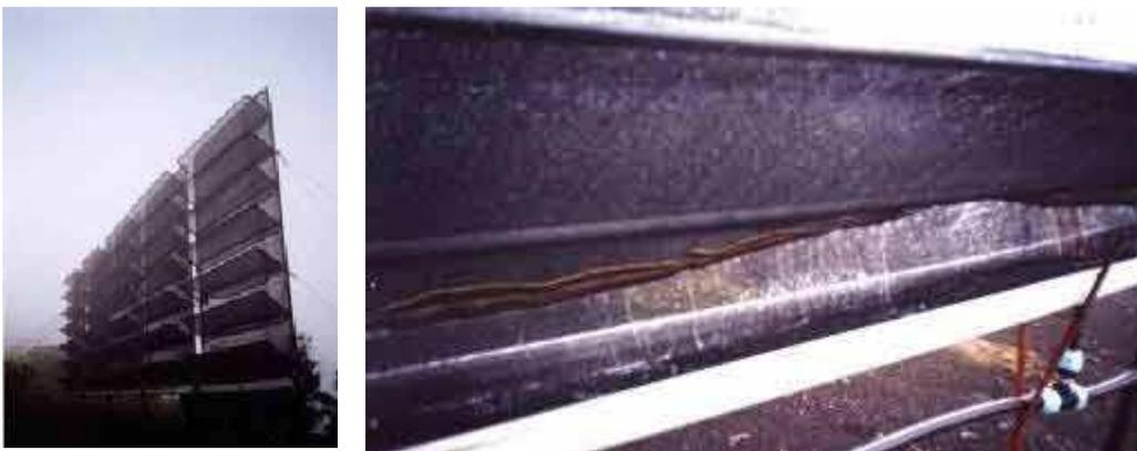
*Detalle de la recogida del agua de niebla captada en el canalón del equipo*
