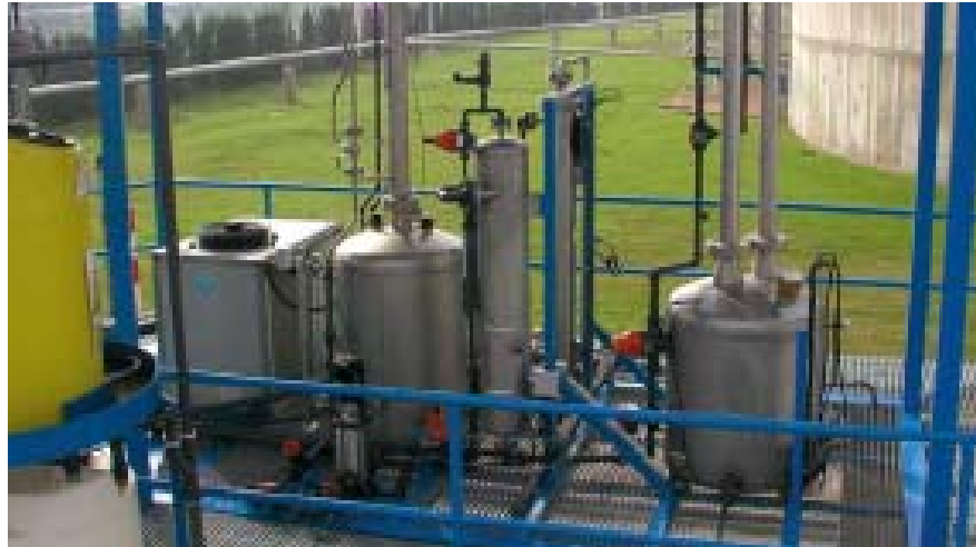
Figura 3. Etapa de separación de CH 4 y CO 2
