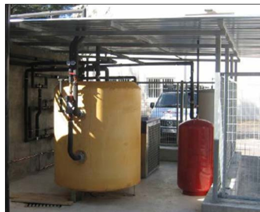
Figura 32. Instalación de la UMU.
