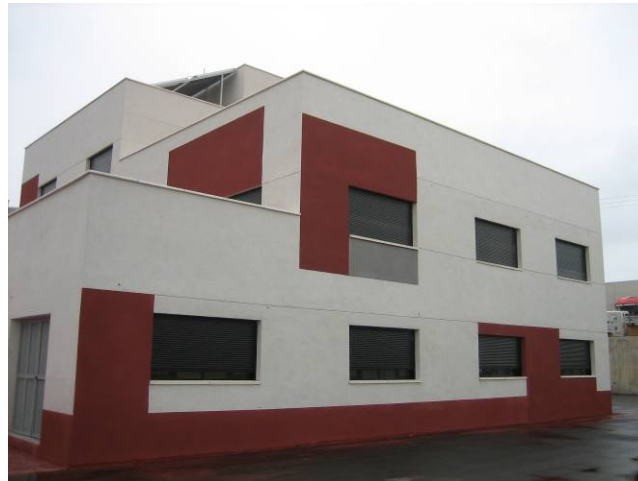
Figura 16. Centro de Nuevas Tecnologías, Energías Renovables y Empleo de Molina de Segura.
