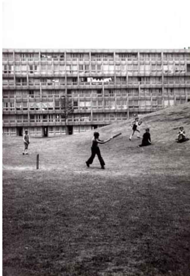
2.- Robin Hood Gardens, Londres. Alison y Peter Smithson. Montaña del jardín construida con los escombros de la construcción.
