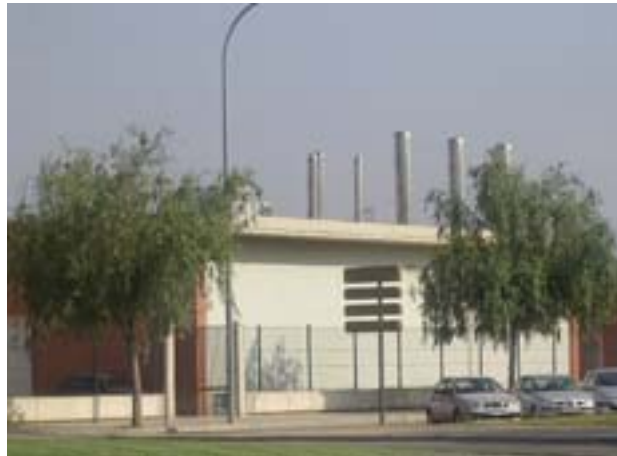
Fotografía 1. Edificio de calderas de calefacción del campus de Vera
