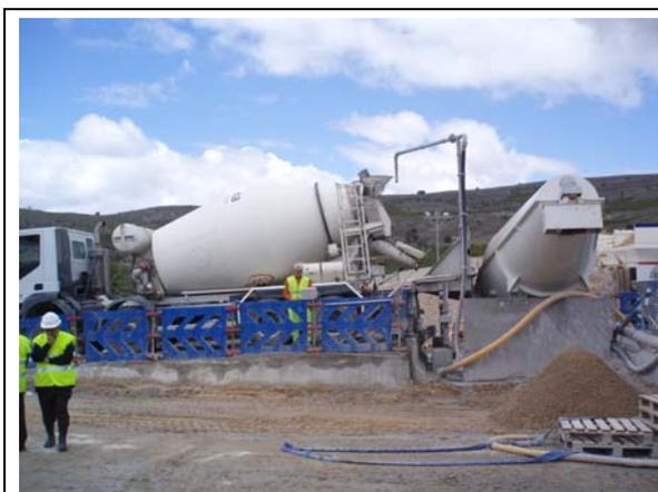
**Fig. 2. Hormigonera en proceso de lavado en el reciclador**
