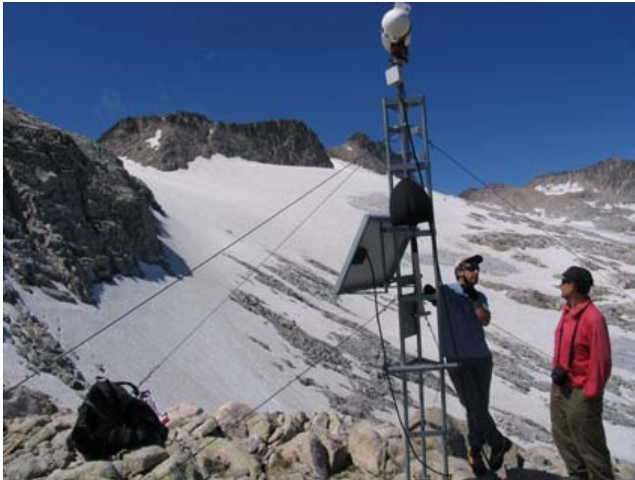
Figura 3: torre de alimentación eléctrica y glaciar de Aneto al fondo (Septiembre 2007). Foto: J. del Valle.
