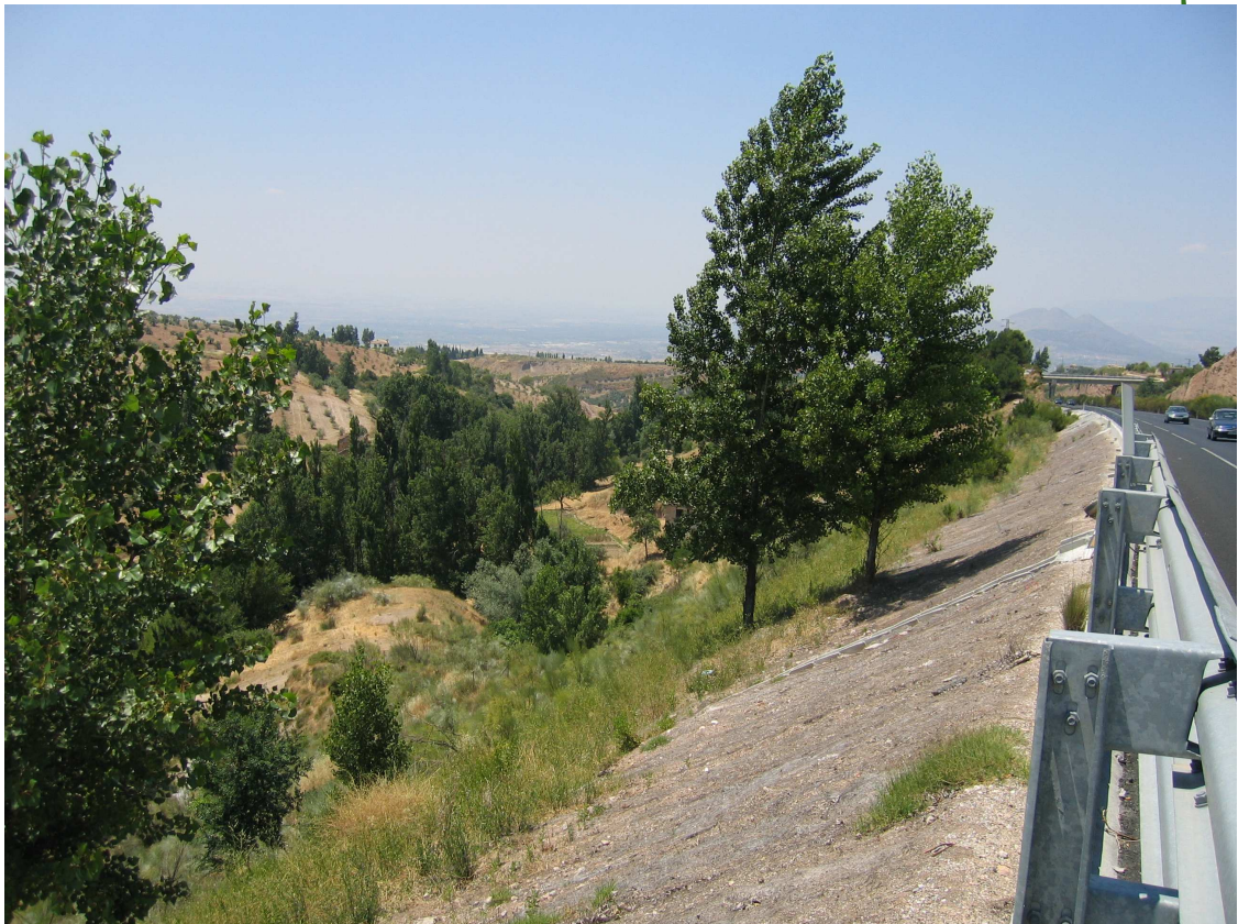
Foto A-92. Viznar (Granada): tratamiento herbicidas sobre los taludes hidrosembrados y cubiertos con mantas.
