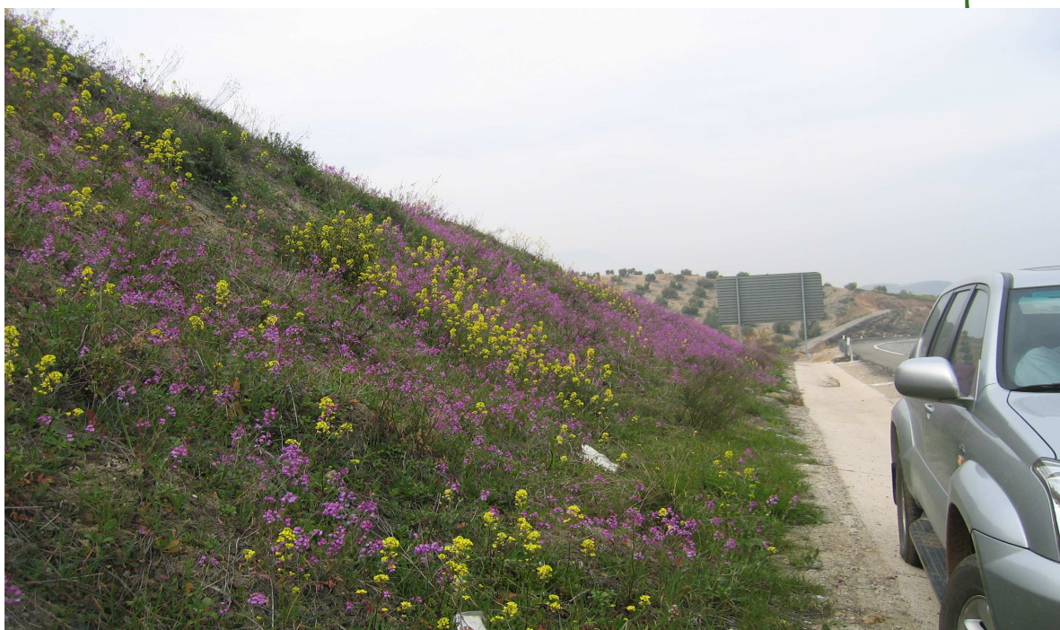
Foto A 44. Jaén: talud estabilizado definitivamente con diversidad de vegetación y sin erosión, ejecutado con hidrosiembra y manta orgánica.
