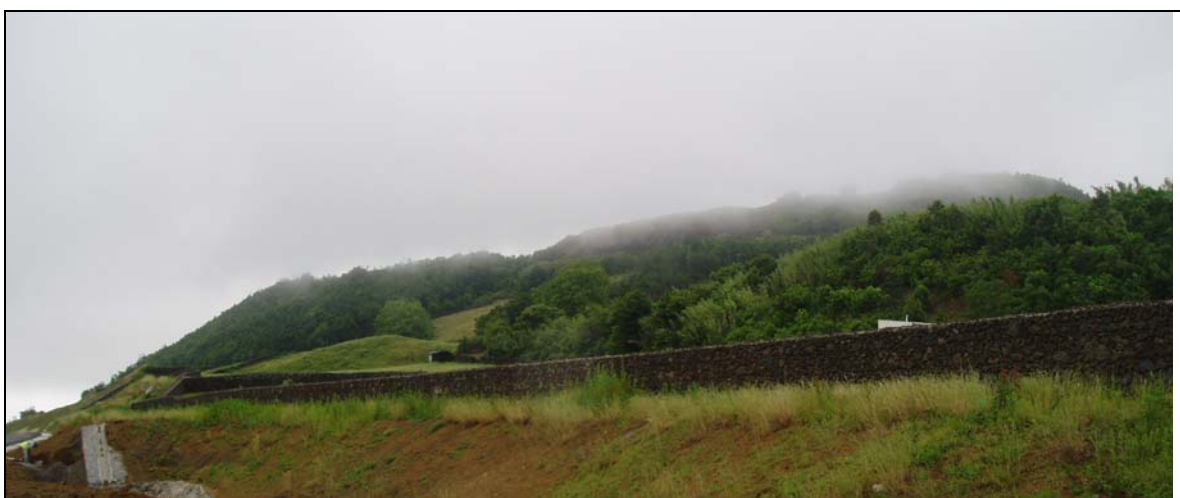
Muro de piedra de la autopista
